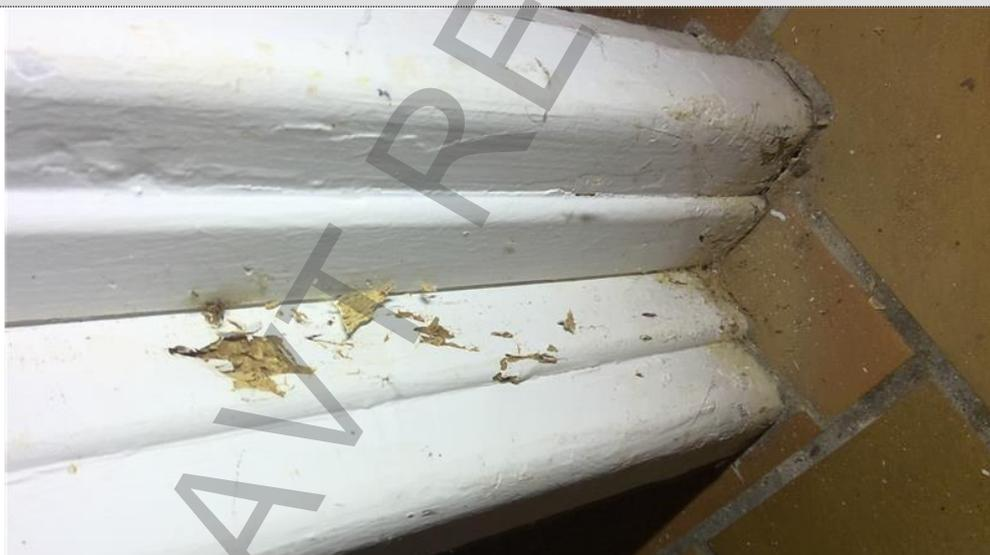
Résultat du diagnostic : Trace de passage de Indice d'infestation d'agents de dégradations biologiques du bois avec altération biologique Altérations dans le bois
